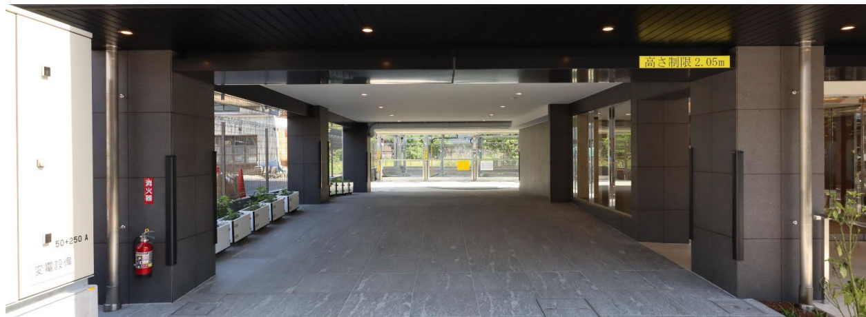
スロープ付き車路
