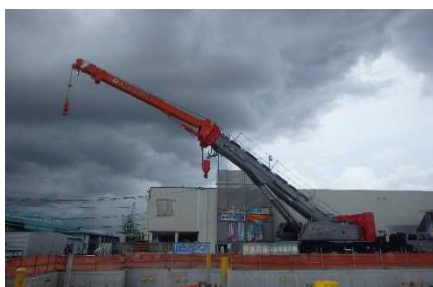
ラフタークレーンによる施工
